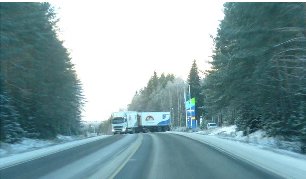
Kuva 21. Kaukjärven huoltoaseman liittymä valtatiellä 10 (idästä).
