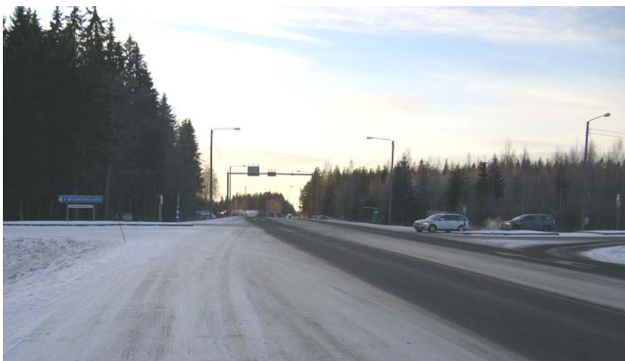
Kuva 16. Turuntien ja Murronkulmantien nelihääriliittymä.
