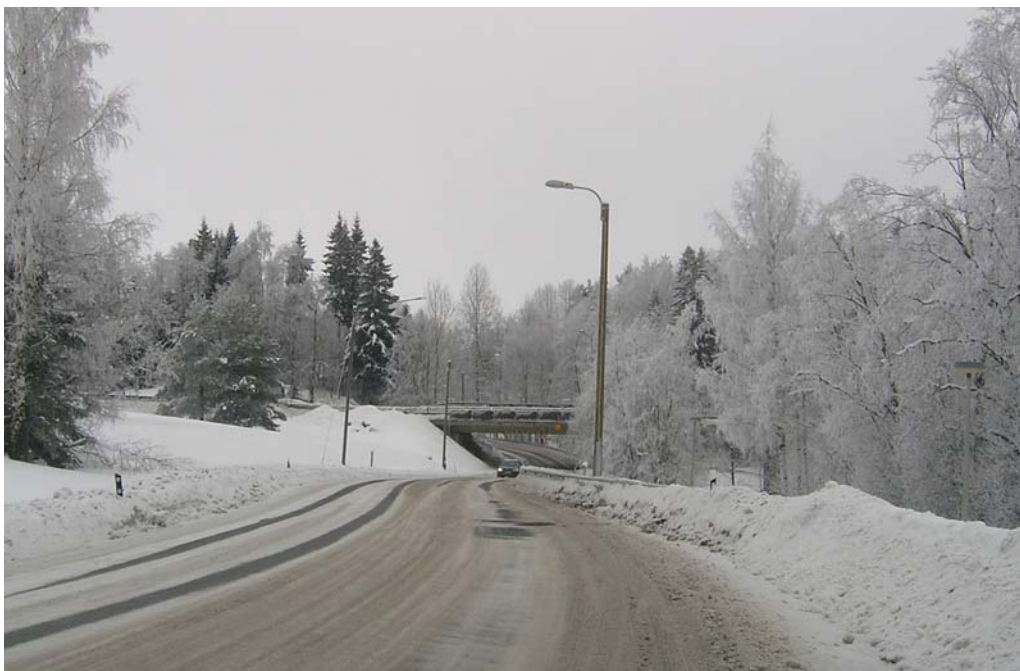
Kuva 19. Vieremäntie valtatie 10 alituksen kohdalla.
